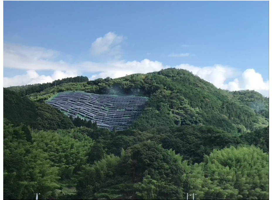
和歌山県の山の斜面設置(森林伐採?)の例
